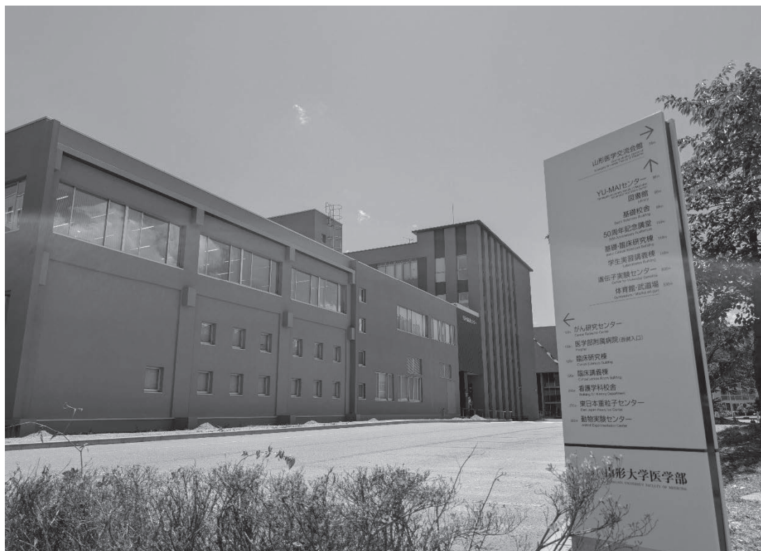
写真 1: 改修後の医学部図書館。奥に YU-MAI センターが連結している。
