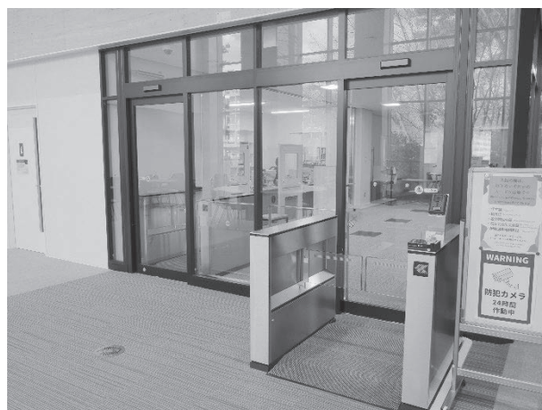
▲エントランスホール内入退館ゲート
