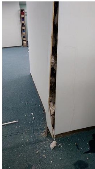
柱の損壊 (2 階)
