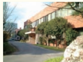
▶ 白ずめの建物が建ち並ぶなか、煉瓦色の2階建てはすぐ目にとまります
