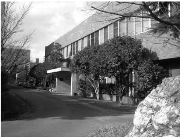
農学分館外観（右端が岩の一部）
