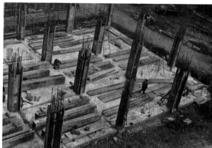
農学分館建築現場
