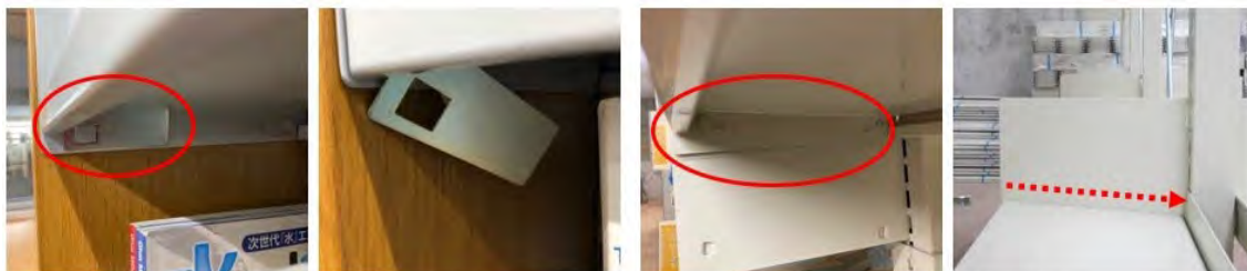
工学分館 元職員の独自開発によるアタッチメント ※写真右は、今回の地震により外れた状態
