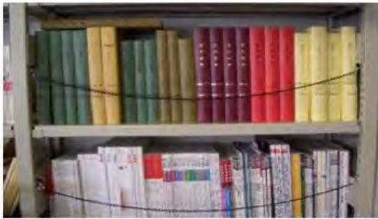
工学分館 事務室 職員作業用書架<チェーン> ※落下しなかったが、利用者エリアには使いづらい
