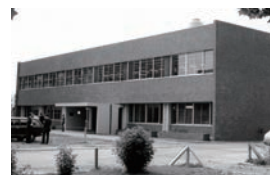
農学分館(1979年竣工)
