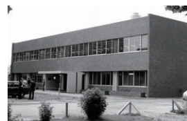
農学分館(1979年竣工)
