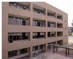
本館2号館(1989年竣工)
