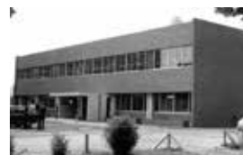
農学分館(1979年竣工)
