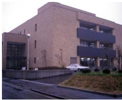
北青葉山分館(1985年竣工)
