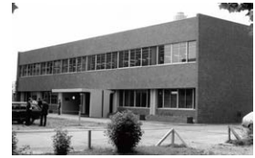
農学分館(1979年竣工)
