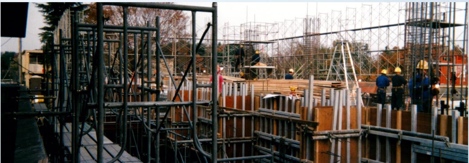
新館建設中の様子（旧館2階より撮影）
