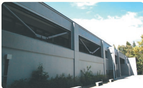
▶本館玄関付近
